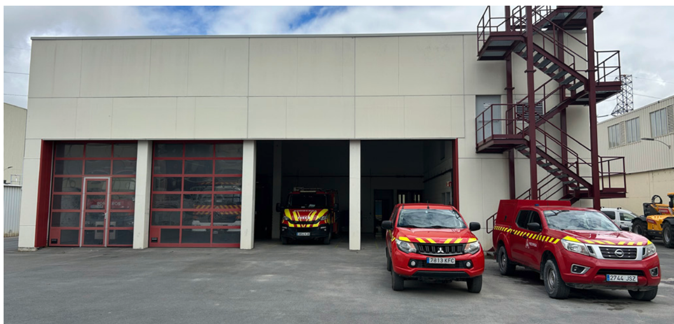
Edificio de bomberos de la fábrica de Mercedes-Benz Vitoria
