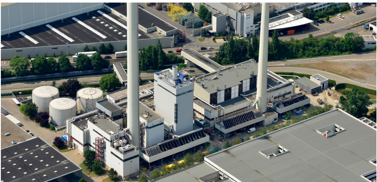
Heizkraftwerk Standort Sindelfingen
