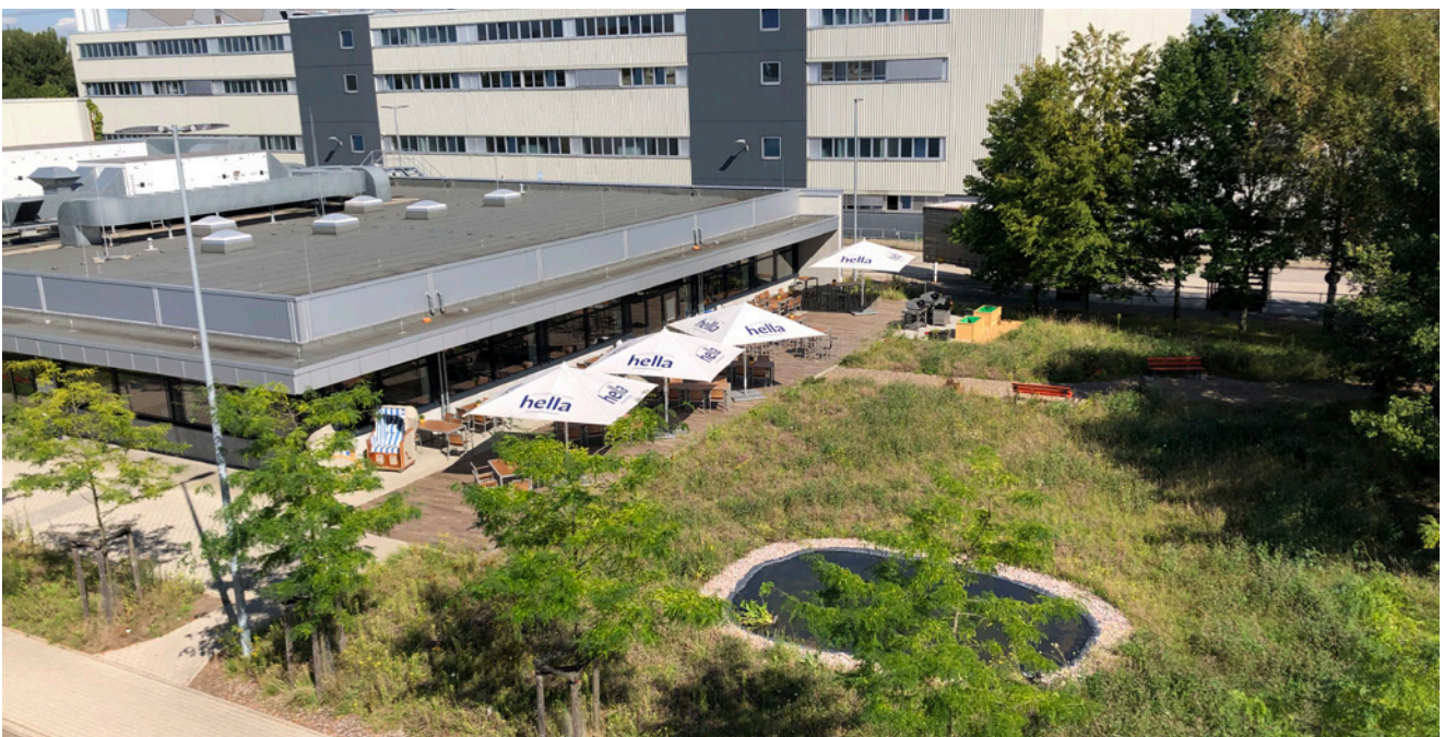
Abbildung 7 IST-Zustand der Projektfläche vor der Kantine (links)
