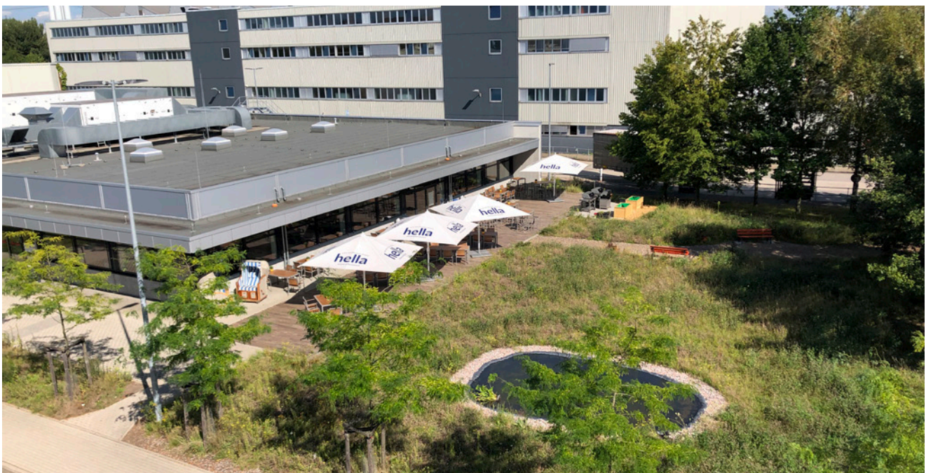
Abbildung 7 IST-Zustand der Projektfläche vor der Kantine (links)
