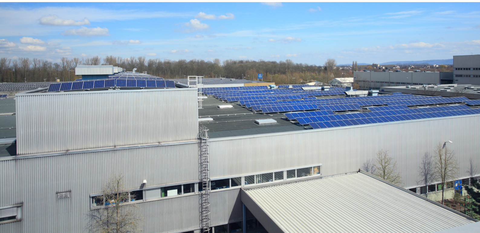
Photovoltaikanlage im Werksteil Rastatt.
