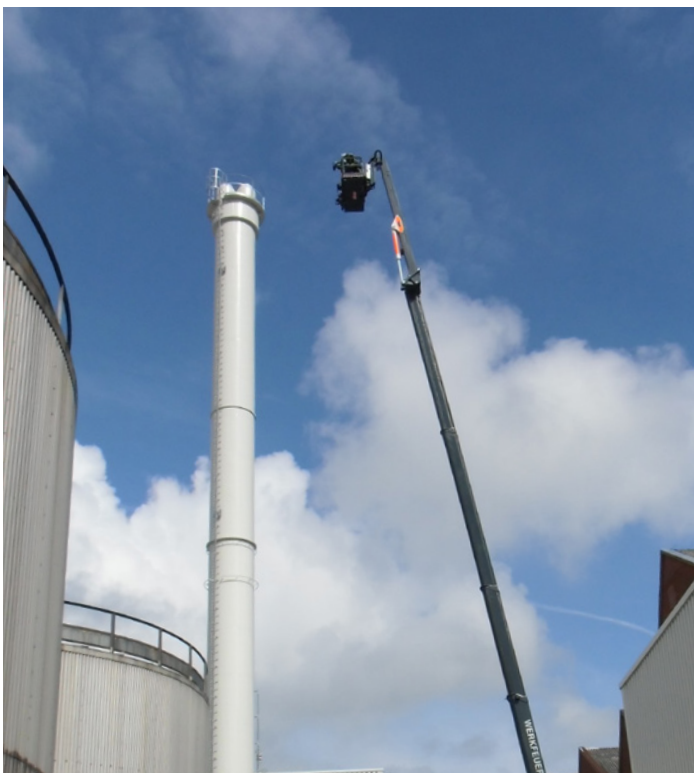
Schallschutzmessung an einem BHKW-Kamin.
