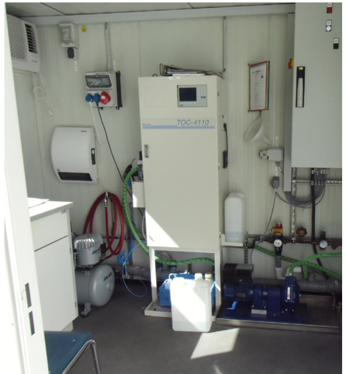
Kanalüberwachung mittels TOC-Messung.
