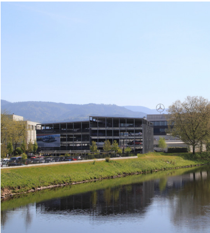
Parkhaus in Gaggenau für Mitarbeiter und Werksverkehr.
