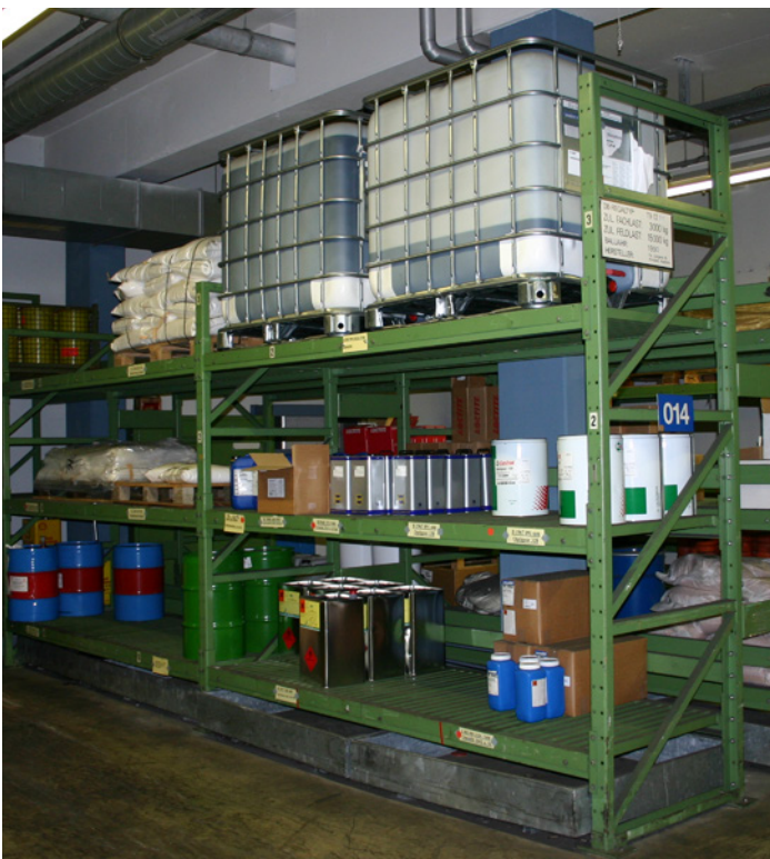
Lagerung im Gefahrstofflager.
