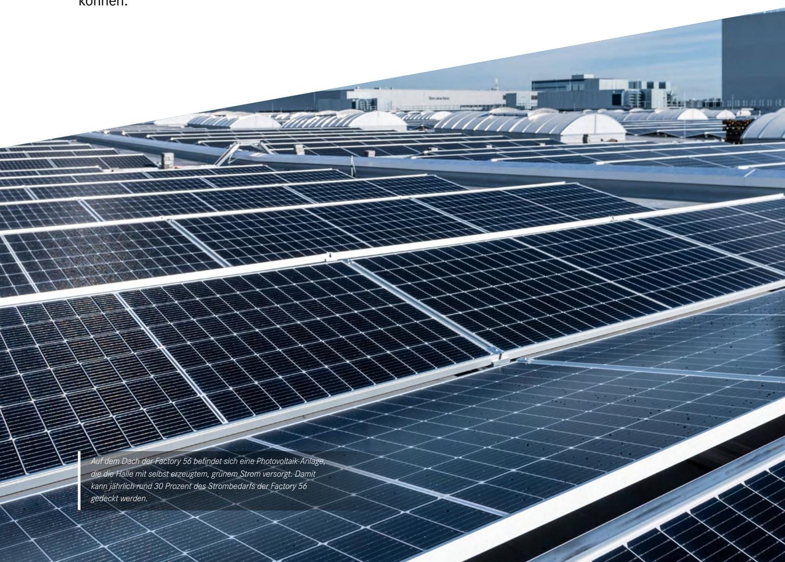
Auf dem Dach der Factory 56 befindet sich eine Photovoltaik-Anlage, die die Halle mit selbst erzeugtem, grünem Strom versorgt. Damit kann jährlich rund 30 Prozent des Strombedarfs der Factory 56 gedeckt werden.
