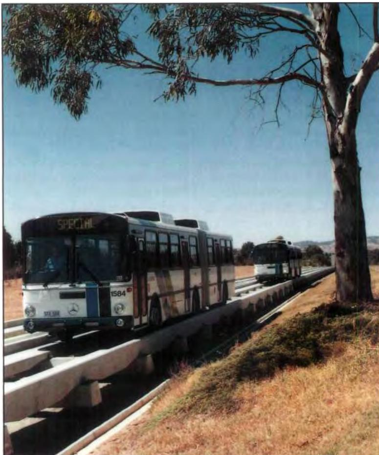
Auch in Adelaide, Australien, wird das von Daimler-Benz entwickelte O-Bahn-System eingesetzt. Die spurgeführte Busbahn gehört zu den modernsten Systemen des öffentlichen Personennahverkehrs und zeichnet sich vor allem durch hohe Wirtschaftlichkeit aus.
