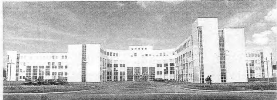
Das Daimler-Benz Forschungszentrum in Ulm – hier der erste Bauabschnitt.
