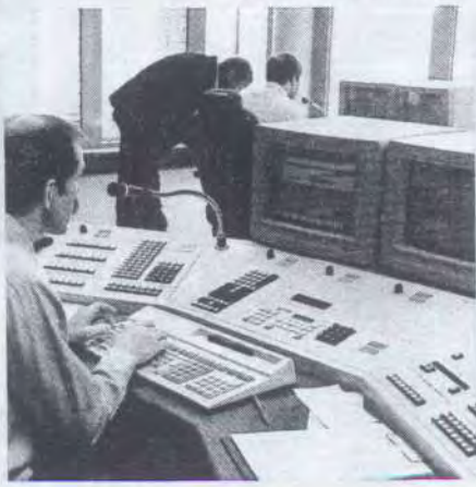
Abfrage-Vermittlungssystem 1280 bei der Feuerwehr Remscheid.
