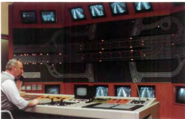
Von AEG gelieferte zentrale Betriebs- und Kontrollwarte zur Überwachung und Steuerung des Verkehrsflusses im Ernstunnel.
