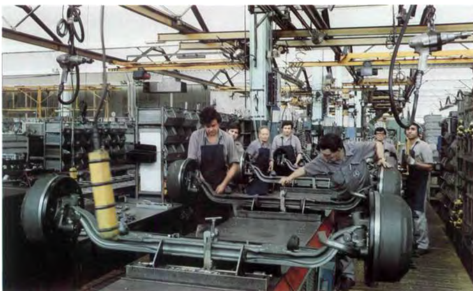
Montage von Vorderachsen für Nutzfahrzeuge bei der Mercedes-Benz Argentina
