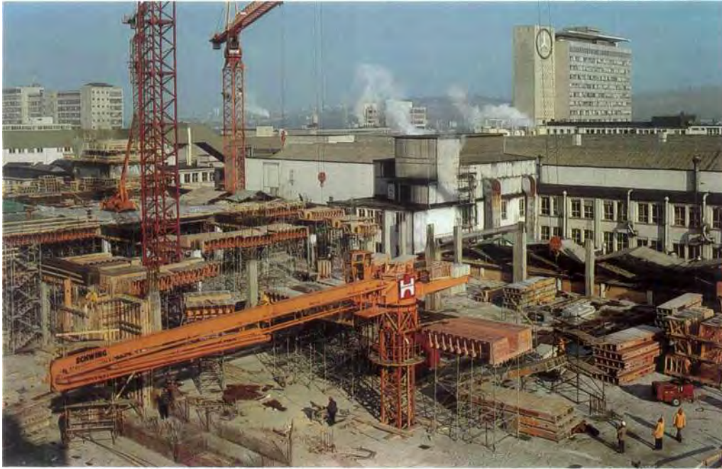
Neubau für die Motorenmontage im Werk Untertürkheim.
